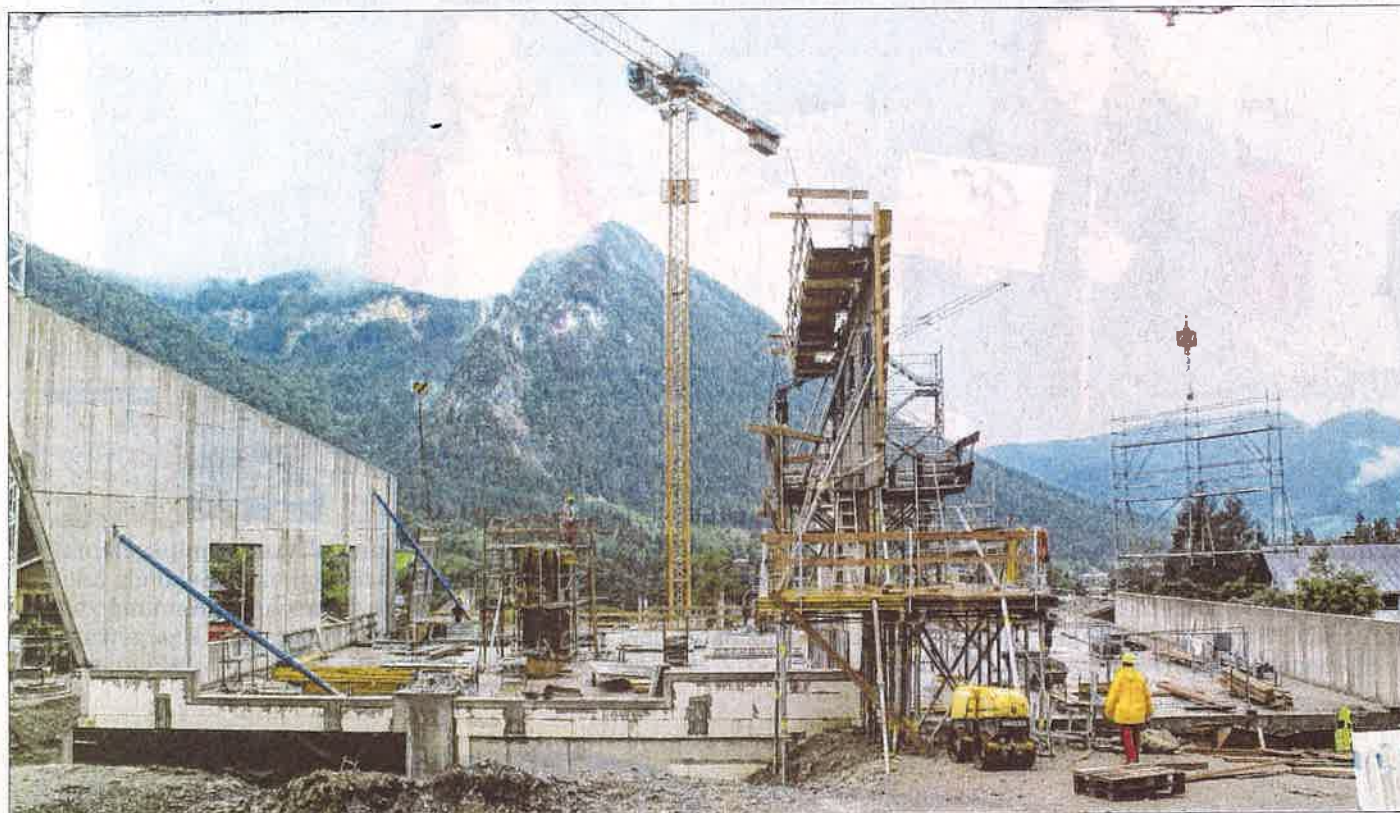
Am Seilbahngebäude der Talstation werden aktuell die Flügelwände errichtet.
