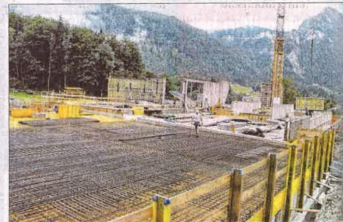
Beton und Baustahl soweit das Auge reicht.
