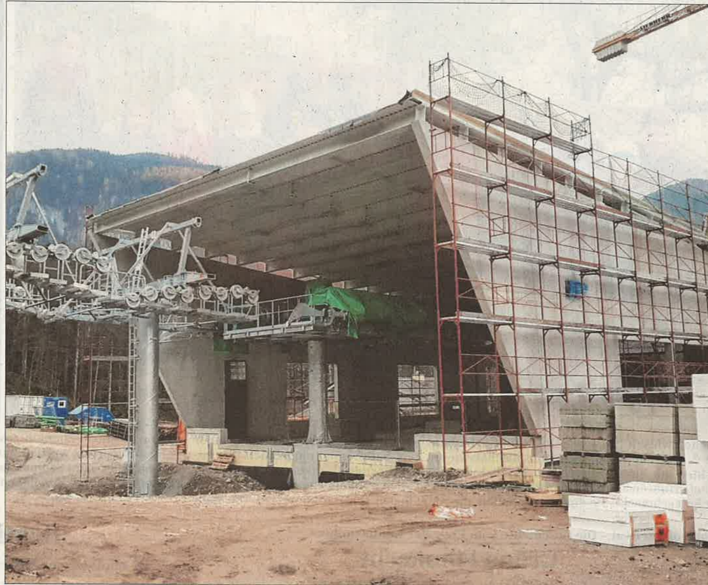
Weitere Stützen für die Jennerbahn werden in den kommenden Wochen per Hubschrauber installiert. (Foto: Pfeiffer)
